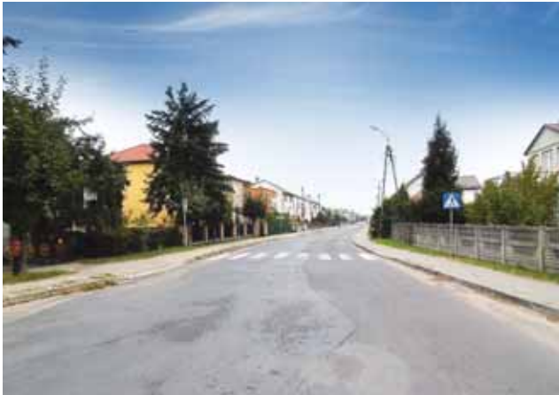
Planowany do przebudowy odcinek ulicy Rypińskiej
