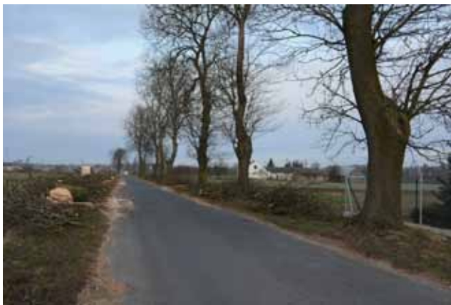
Trwają przygotowania do wymiany nawierzchni w Wąpielsku
